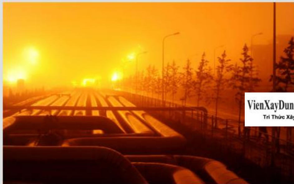
Đường ống dẫn dầu cháy ở Đại Liên năm 2010.
